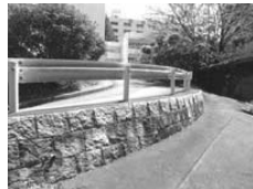
段差とガードレール ( )
